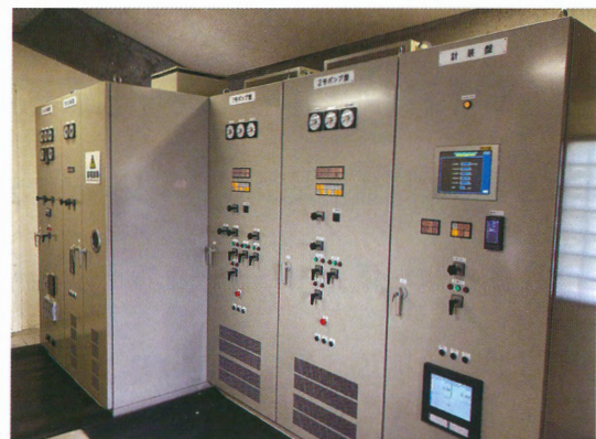
山本新田支線揚水機 電気設備整備
