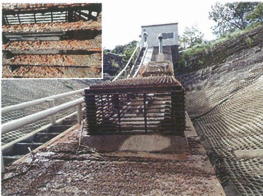
蔵王ダム取水スクリーン（整備前）
