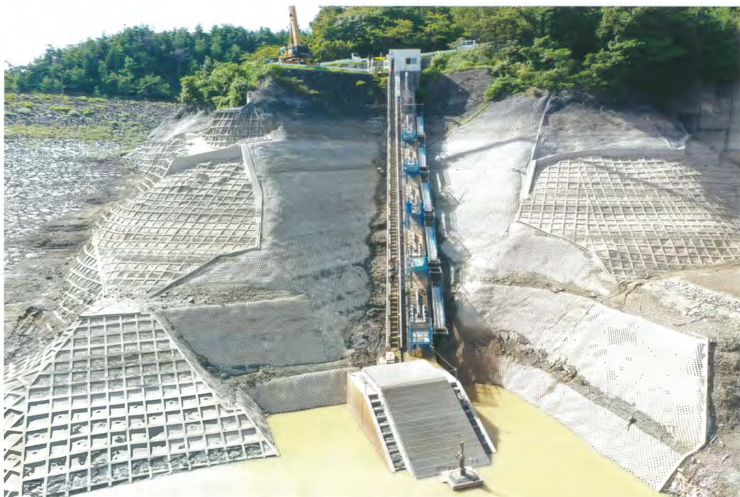
蔵王ダム 取水スクリーン更新
