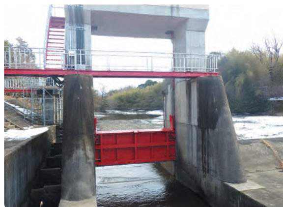
土砂吐ゲート塗替塗装 整備後
