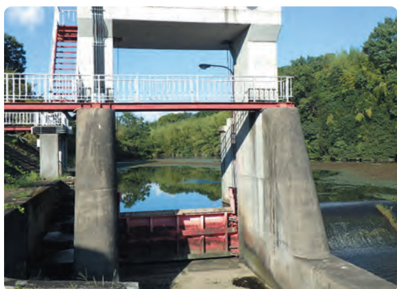
土砂吐ゲート塗替塗装 整備前
