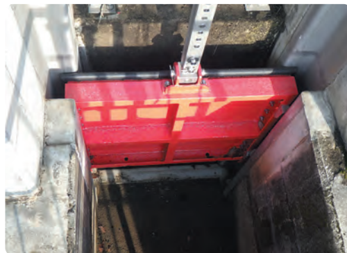
取水ゲート（右岸2） 整備後
