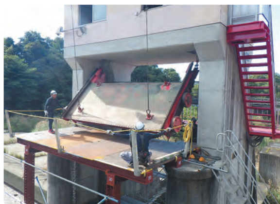
土砂吐ゲート 扉体搬出中
