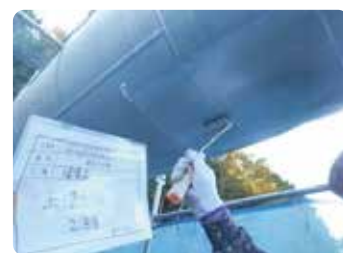
水管橋 部分塗装
