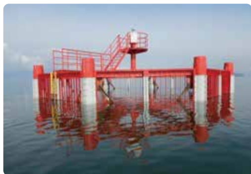
取水塔 整備後
