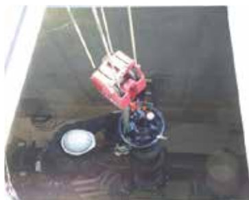
電動開閉器（11号）
