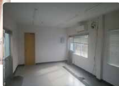
蓮花寺頭首工 建屋改修
