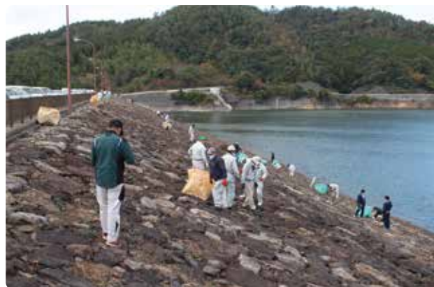
【堤体の清掃作業】
