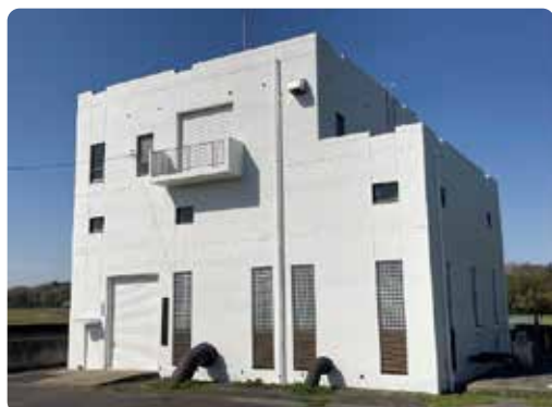
第3段揚水機場 建屋改修
